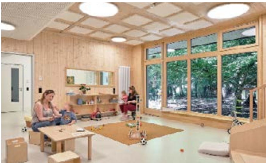
Inklusive Kita am Auwald: Außen- und Innenwände aus tragenden Brettschichtholz-Scheiben
